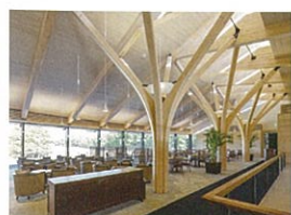
古賀ゴルフ・クラブクラブハウス 妹尾賢二・高橋央・吉田勝 (株)日建設
