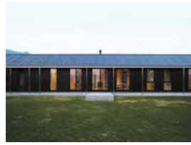
T.house in 高森 西山英夫 西山英夫建築環境研究所 熊本県高森町
