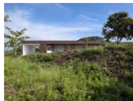
飯塚の家 松本匡弘 松本匡弘建築設計事務所 福岡県飯塚市
