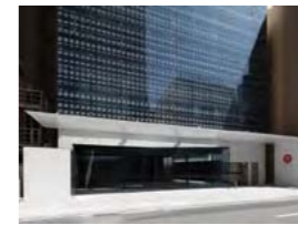
KYOURAKU BUILDING 西山雅彦・川崎拓二・今林光秀 (株)日本設計 福岡県福岡市
